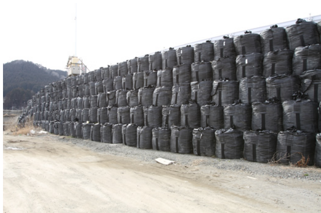
土嚢の内容物として利用されるコンクリートが れき
