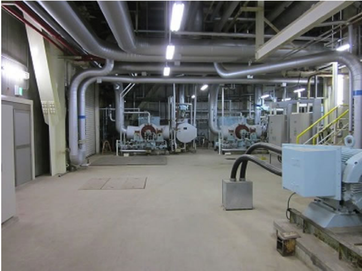
復旧したタービン本館1階
