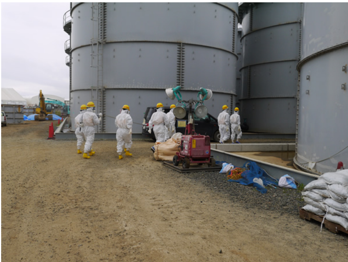
写真1 福島第一原発の巨大な汚染水タンク。同種のものが約1000基も建設された。
