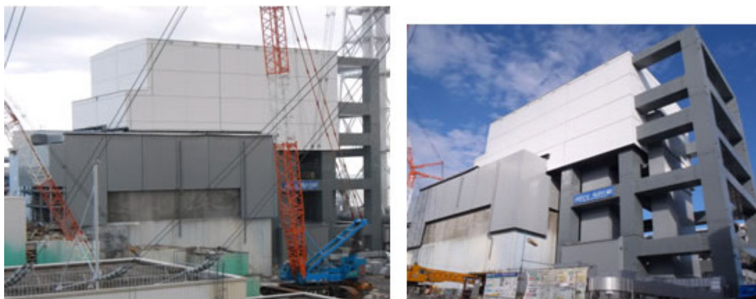
写真7・補強された4号機の概観。東電資料より
