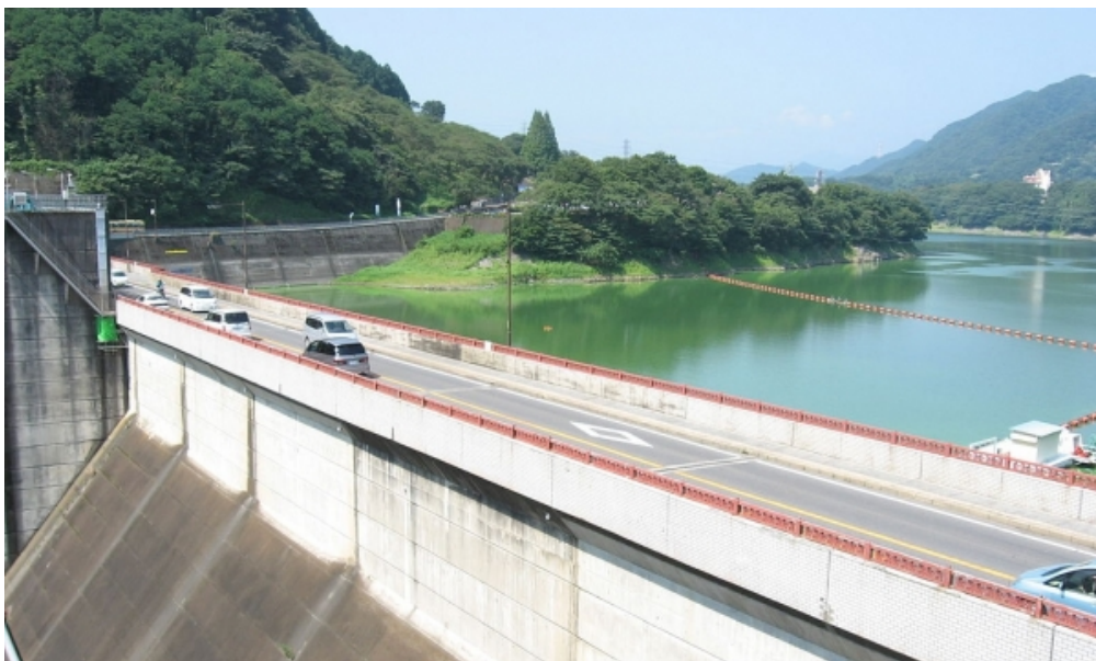
城山ダムの天端を走る国道413号 (Wikipedia)
