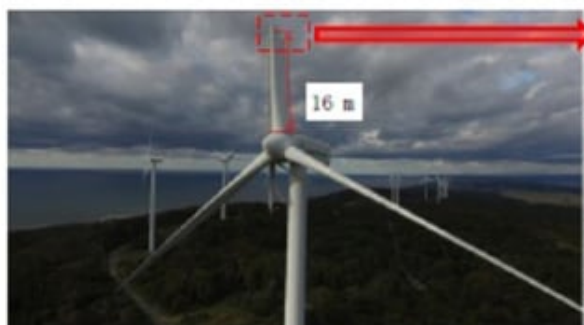
図-1 13号風車ブレード折損状態
